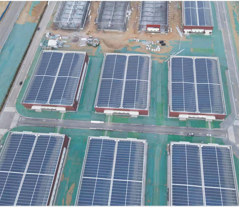
陕西省榆林市BIPV光伏建筑一体化22兆瓦项目展示
