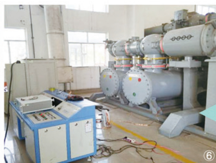
⑤ 220kV 车载平台 GIS CT 误差检测
