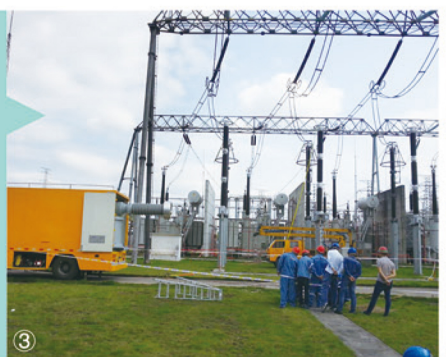
③ 500kV 车载平台 CVT 误差检测
