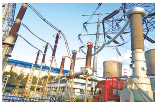
德州茌平电厂 220kV GIS 耐压试验
