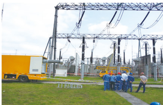
广东 500kV 北郊变 CVT 误差试验
