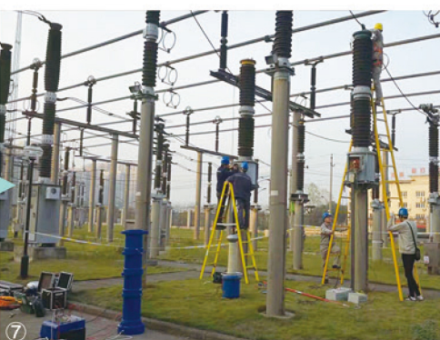
⑦ 220kV 分体设备 CVT 误差检测
