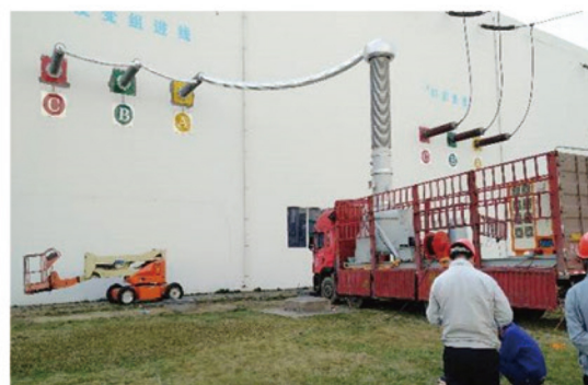
华电青岛电厂 220kV 穿墙套管耐压试验
