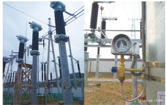
霸州 500kV 站 CT 接头更换及下引工程
