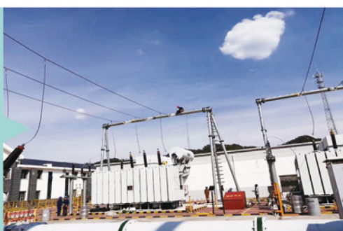
线路维护检修
