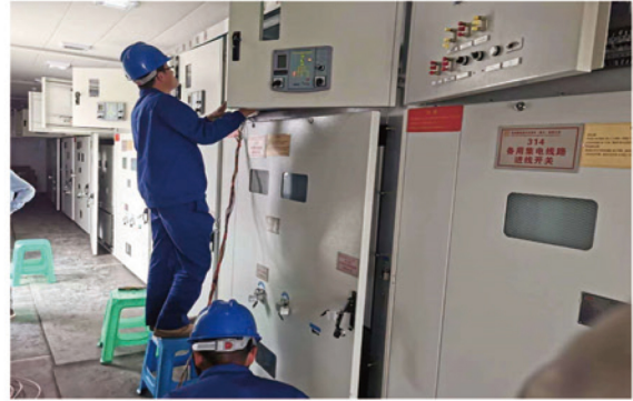
山东枣庄 35kV 羊庄变检修维护
