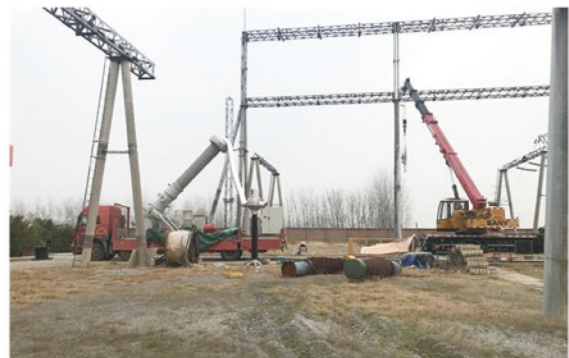
淮北国安 220kV 升压站 # 1 主变 2701 , # 2 主变 2702 流变换型改造工程
