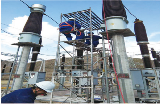
山东滨州 110kV 下洼变电站维修工程
