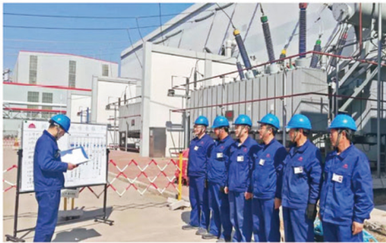
国家能源泰安热电厂整站检修试验
