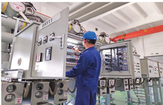
云南红河 110kV 河湾变单母线改造工程
