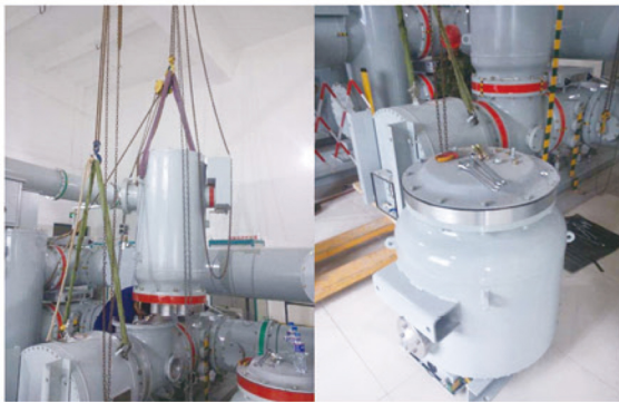
山东泉沟 110kV 共箱 GIS CT PT 现场更换
