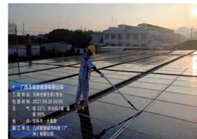
玉柴厂区光伏项目
