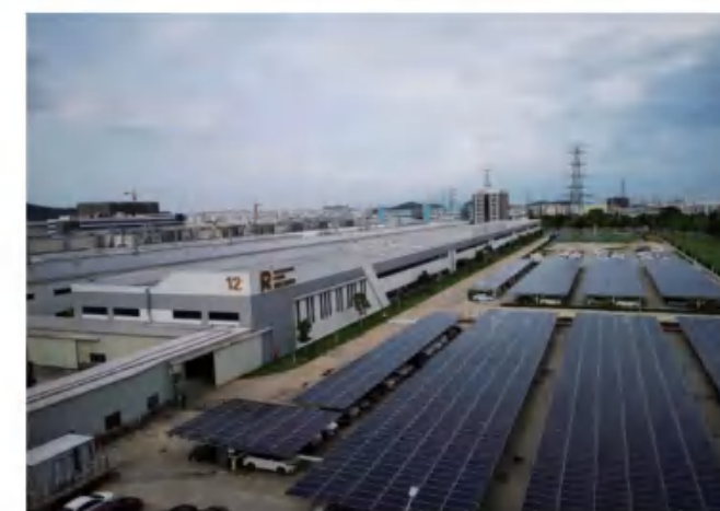
广州发展新能源·珠江钢琴光伏项目
