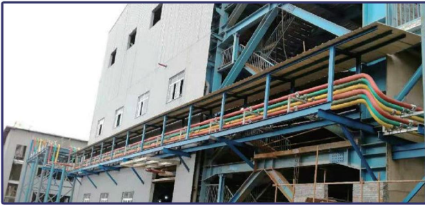
印尼OBI镍铁项目配套电厂工程
