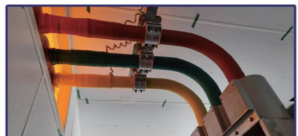
湖南湘电动力项目
