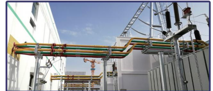
蒙苏经济开发区隆基新能源科技产业园项目
