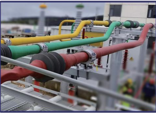
国网郑州市区220千伏变扩建工程
