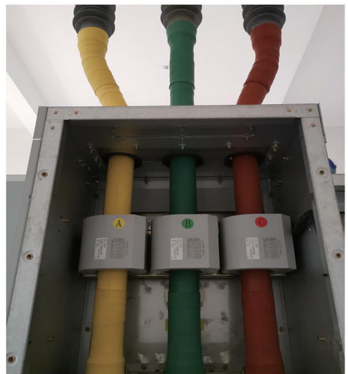
内锥式绝缘套管安装施工图
