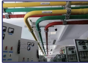
国网浙江宁波绝缘母线工程
