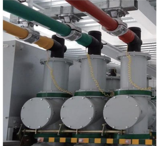
外锥式绝缘套管安装施工图
