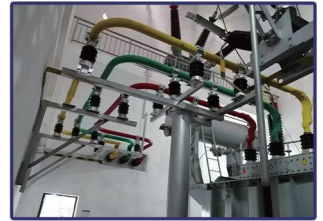
国网济南220kV变电站扩建工程
